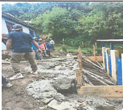
Foto 3: Construcción de muro de contención.
