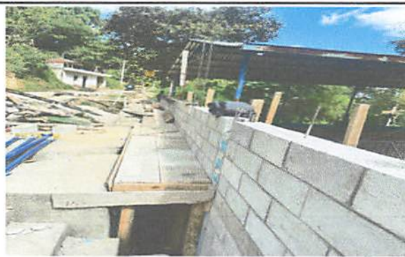
Foto 4: Continuación de muro perimetral
