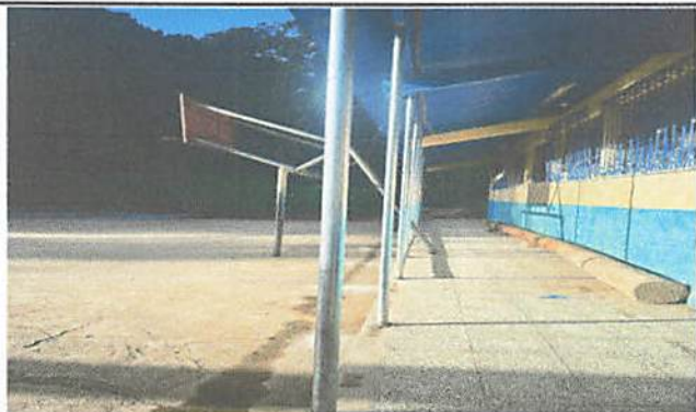
Foto 1: Instalación de tubos para colacar electromalla.
