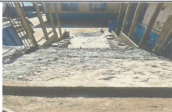
Foto 2: Construcción de rampa de entrada.
