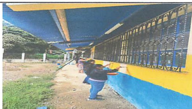
Foto 6: Aplicación de nueva pintura.
