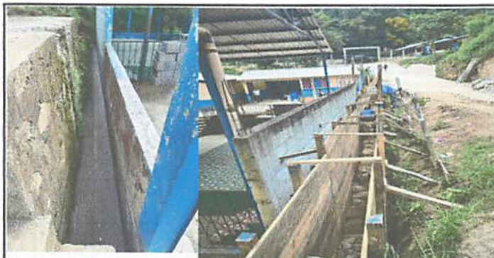
Foto 5: Proceso de fundición, cubrimiento de cuneta de entrada y continuación del muro de contención
