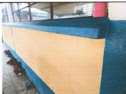
Foto 6: Pintura de salones y cocina interior y exterior
