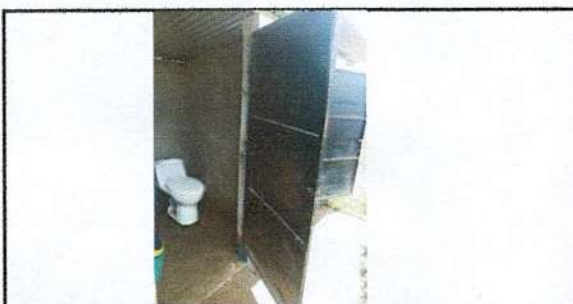
Foto 5: Mantenimiento de puertas de sanitario
