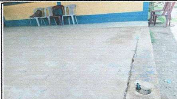
Foto 2: Mantenimiento de losa de patio
