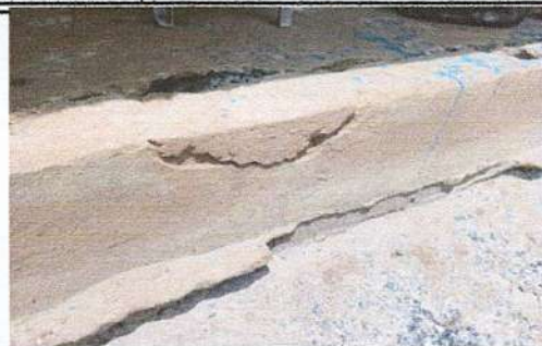
Foto 1: Mantenimiento de losa de patio
