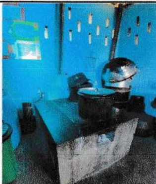
Foto 3: Remodelación de pollo de cocina
