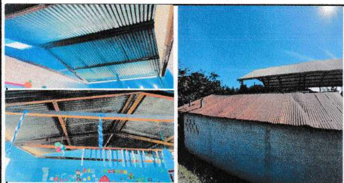
Foto 5: Cambio de lámina y estructura metálica en salones y cocina
