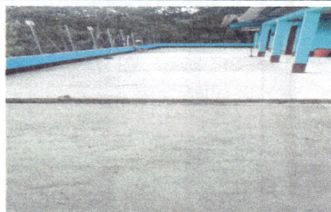
Foto 6: sustitución de piso torta
