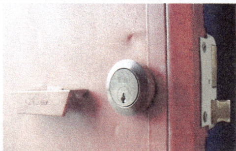
Foto 5: Sustitución de chapa
