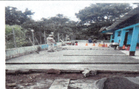
Foto 6: sustitución de piso torta
