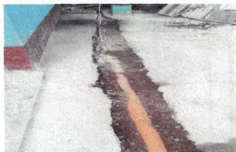
Foto 4: Elaboración de zanja y colocación de tubería
