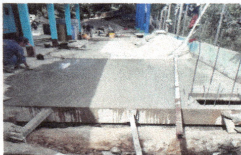
Foto1: Mejoramiento de cisterna de agua
