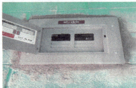
Foto 2: Cambio de tablero de electricidad
