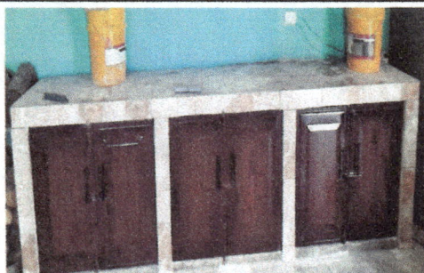
Foto 3: Reparación y mejoramiento de mueble de cocina
