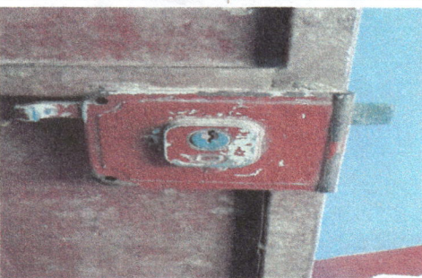
Foto 5: Sustitución de chapa
