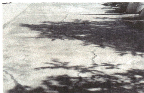
Foto 6: sustitución de piso torta
