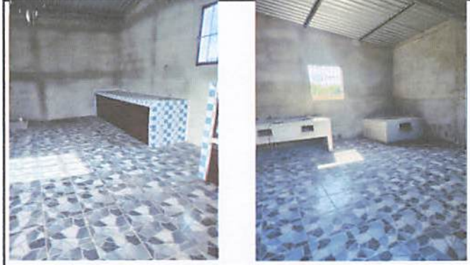
Foto 2: Finalización de polleton y repello en paredes de cocina.
