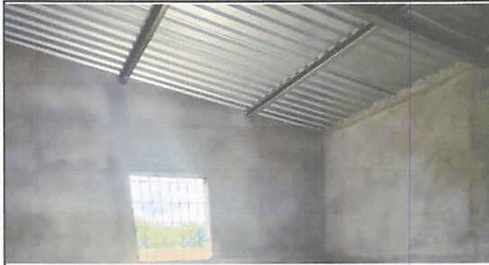
Foto1: Finalización del techado y estructura en cocina.
