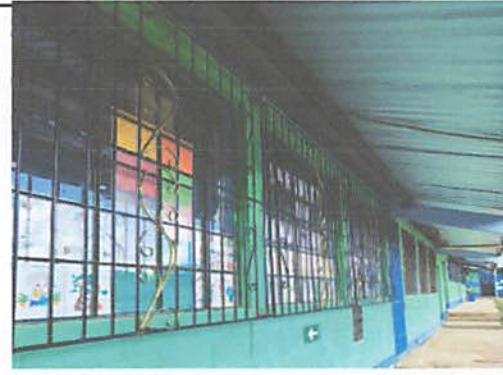
Foto 4: Instalación completa de balcones a ventanas del centro educativo.
