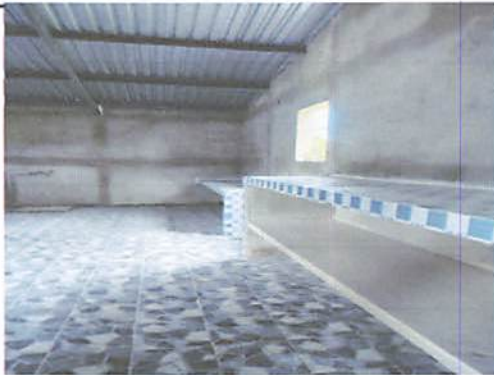
Foto 3: Finalización de la ampliación de cocina.
