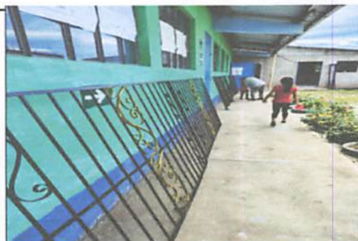
Foto 5: Colocación de balcones a ventanas del centro educativo.
