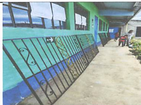
Foto 4: Colocación de balcones a ventanas del centro educativo.
