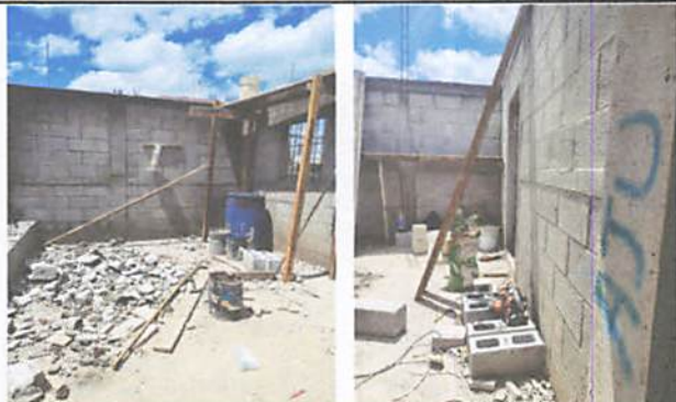
Foto1: Colocación de estructura y techado a cocina.
