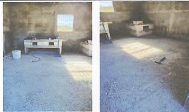
Foto 2: Reconstrucción de polleton y el debido repello a las paredes de cocina.
