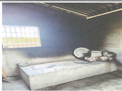
Foto 2: Remodelación de Polleton y repello de paredes.
