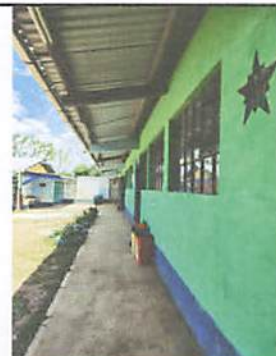
Foto 4: Balcones, para seguridad del centro educativo.
