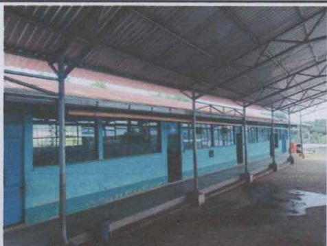
COLOCACION DE BALCONES A VENTANAS DE SALONES, COMEDIR Y COCINA
