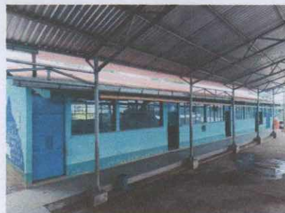
MANTENIMIENTO A CINCO PUERTAS Y PUERTA DE SERVICIO DE COMIDA
