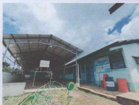
COLOCACION DE CANALES Y BAJADAS DEL SALONES, COMEDOR, COCINA, DIRECCION Y TECHADO DE CANCHA
