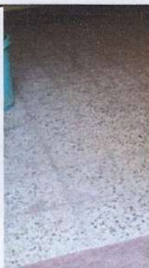
Foto 9: Cambio de piso de baño
