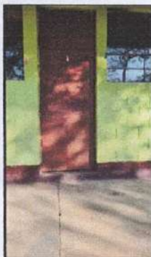
Foto 7: Mantenimiento y pintado de puertas
