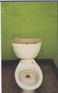
Foto 1: Sustitución de baños y accesorios
