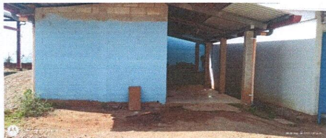
Foto 5: Muro por fuera
