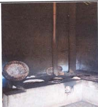
Foto 3: Reparación de poyo
