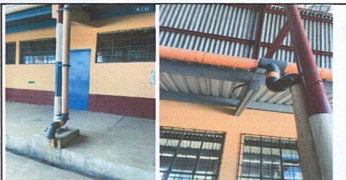
Foto 3: Canales y bajadas de agua pluvial
