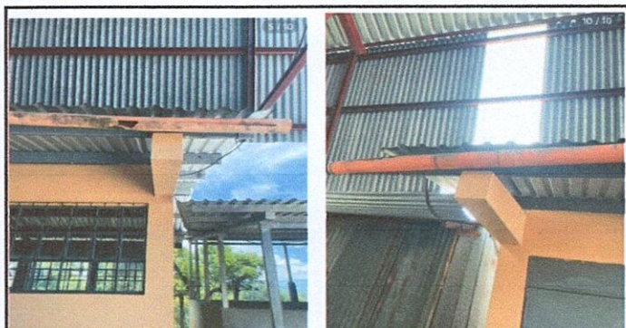
Foto 4: Canales y bajadas de agua pluvial
