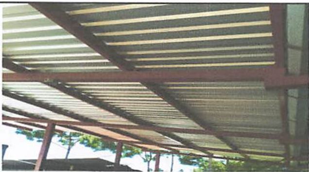
Foto 3: Panorámica del techo con estructura metálica
