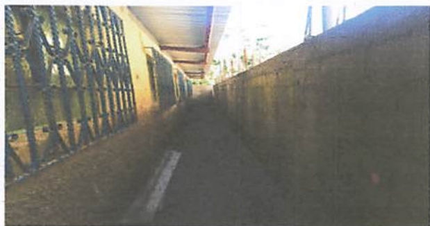
Foto 1: Así queda el muro de contención para proteger el establecimiento
