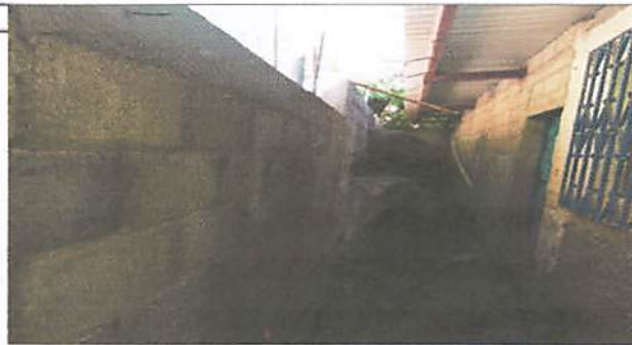
Foto 2: otra toma del muro de contención
