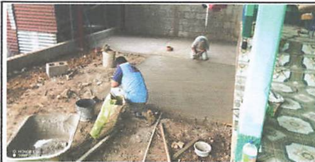
Foto 6: Se logra observar cómo se está fundiendo la loza de cemento
