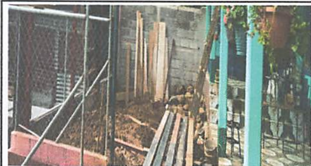
Foto 5: Se logra remover la galera y se rellena el espacio con tierra para luego fundir la torta de cemento.
