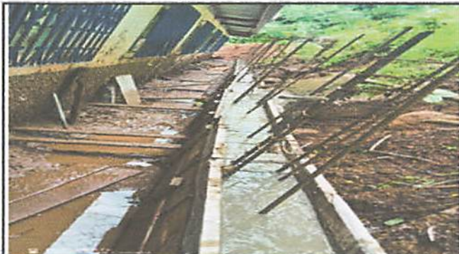
Foto 2: Se reforzaron la fundición del cimiento del muro con piedra hasta una considerable altura
