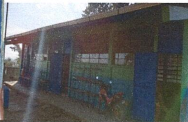
Foto 2: Mantenimiento a estructura de 5 puertas, cada puerta 3 m2 (lijado, cepillado, aplicación de pintura)
