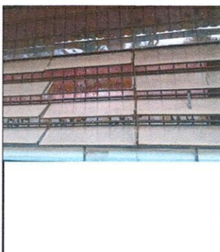
Foto 4: mantenimiento de 11 ventanas de salones de clases varios tamaños incluye (lijado, cepillado, pintura y sustitucion de pegamento de todos vidrios de ventana en mal estado)
