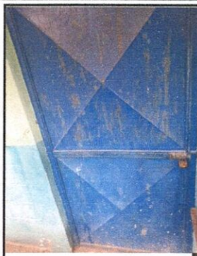
Foto 2: Mantenimiento a estructura de 5 puertas, cada puerta 3 m2 (lijado, cepillado, aplicación de pintura)
