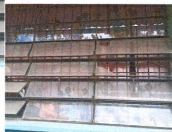
Foto 4: mantenimiento de 11 ventanas de salones de clases varios tamaños incluye (lijado, cepillado, pintura y sustitucion de pegamento de todos vidrios de ventana en mal estado)
