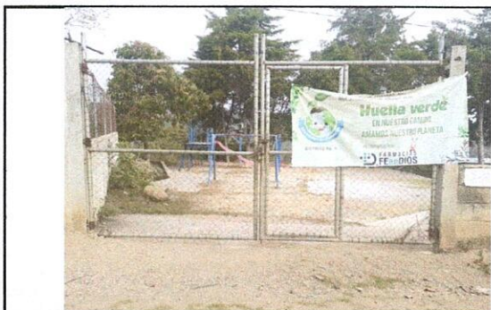
Foto 5: sustitucion de porton metalico de entrada principal de 6 metros de ancho por 2.50 metros de alto (15 m2)
