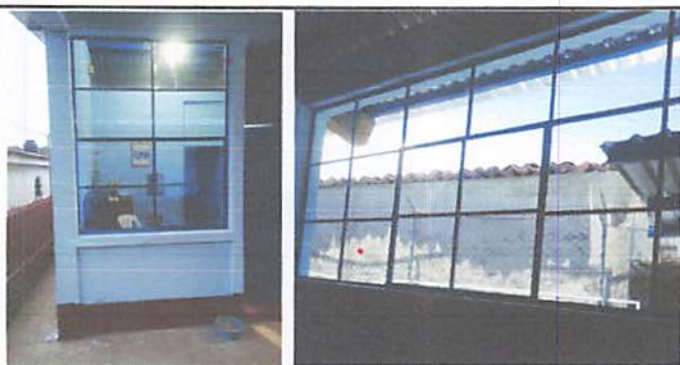
Foto 5: Reparacion de ventanas
