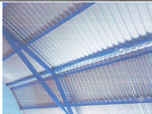
Foto 2: sustitución de estructura de soporte de metal por estructura, porque con mucho aire se levantan las láminas y han tendido muchos agujeros en el atornillado y hace que en invierno gotee el agua
