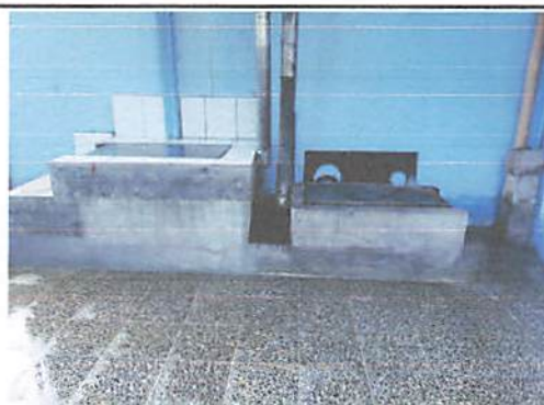
Foto 4: Cocina, piso, plancha
