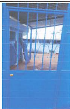
Foto 3: Mantenimiento de porton
