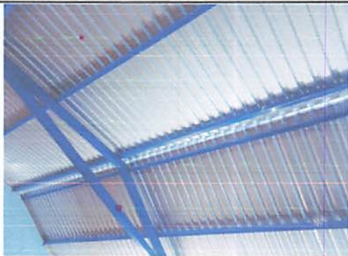
Foto 1: Cubierta de lámina
