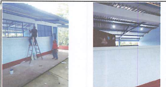
Foto 5: Reparacion de ventanas
