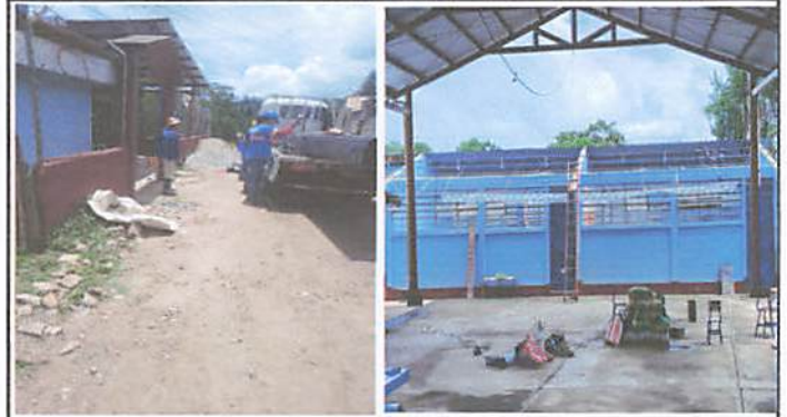
Foto 2: sustitución de estructura de soporte de metal por estructura, porque con mucho aire se levantan las láminas y han tendido muchos agujeros en el atornillado y hace que en invierno gotee el agua
