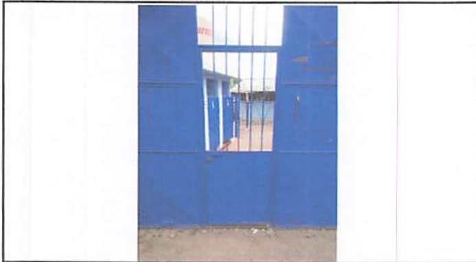
Foto 3: Mantenimiento de porton
