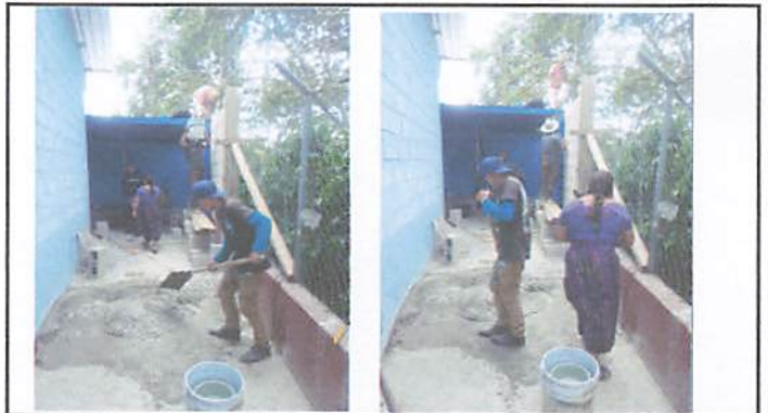
Foto 4: Cocina, piso, plancha
