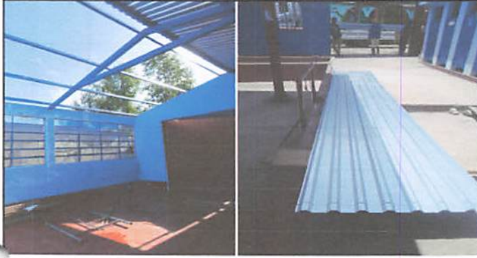
Foto1: Cubierta de lámina
