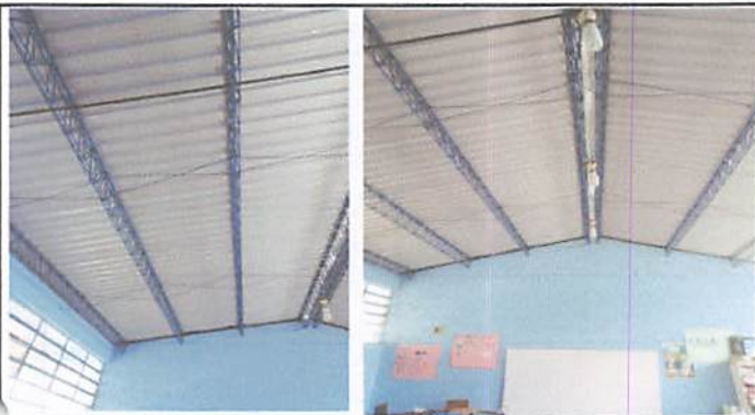
Foto1: Cubierta de lámina
