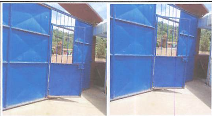
Foto 3: Mantenimiento de porton
