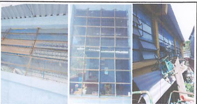
Foto 5: Reparacion de ventanas
