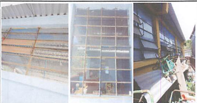
Foto 5: Reparacion de ventanas
