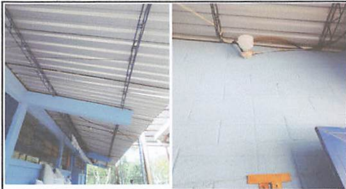
Foto 2: sustitución de estructura de soporte de metal por estructura, porque con mucho aire se levantan las láminas y han tendido muchos agujeros en el atornillado y hace que en invierno gotee el agua
