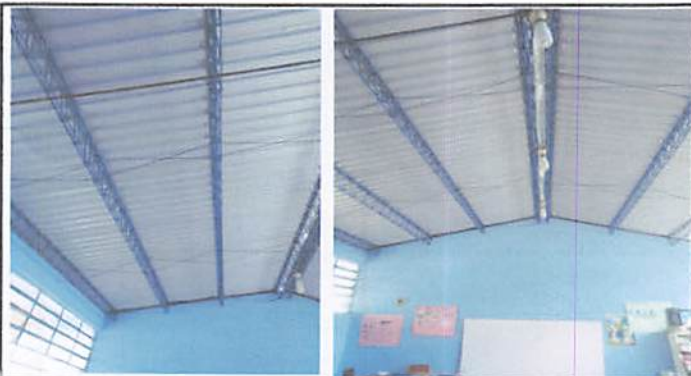
Foto1: Cubierta de lámina
