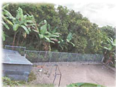
Foto 5: Finalización de 25 metros de malla
