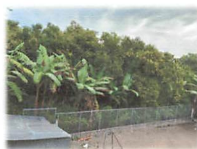
Foto 6: Finalización de malla sobre muro
