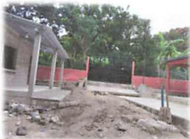
Foto 3: Colocación de porton
