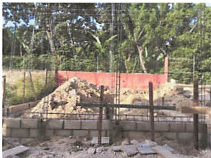
Foto1: Avanzando con los 15 metros de fundición
