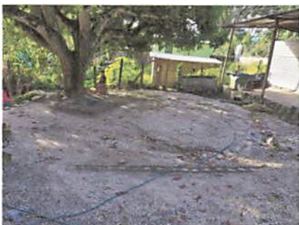
Foto 3: Se necesita una losa de piso
