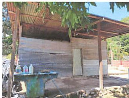
Foto 4: Remodelación de cocina
