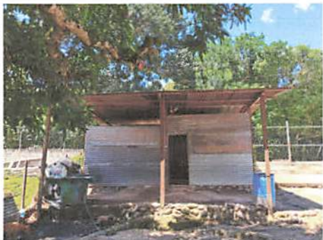
Foto: construcción de cocina
