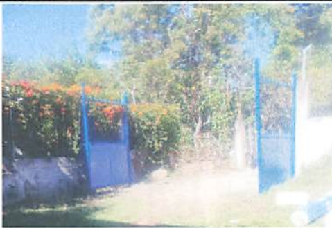
Foto 11: reparacion y pintura de porton principal.
