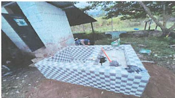
Foto 9: forrado de pila con azulejo.
