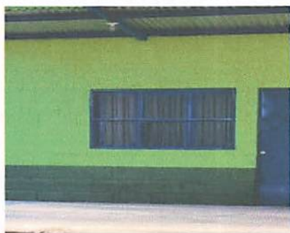
Foto 3: ampliación de ventana, colocación de balcón
