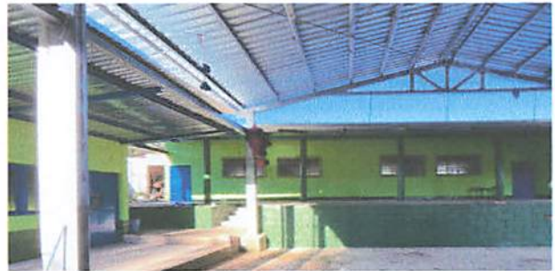
Foto 10: Pintura de interior y exterior de todo el establecimiento
