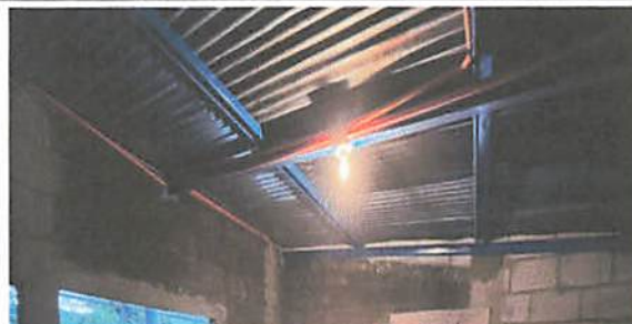
Foto 6: reparación e instalación de tendido eléctrico de la cocina
