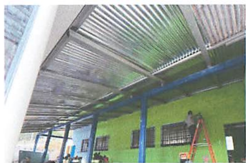
Foto 8: cambio de techo del escenario
