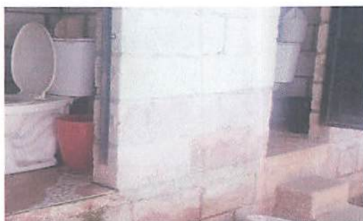
Foto 5: Instalación de 3 nuevos sanitarios.
