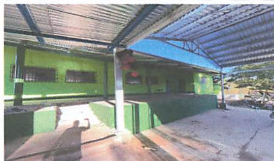
Foto 2: reparación de muro de contención/escenario
