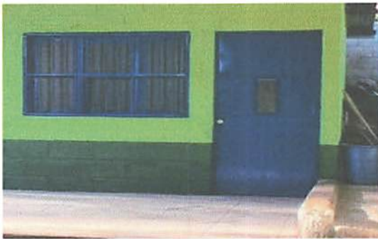
Foto 7: pintura de puertas.
