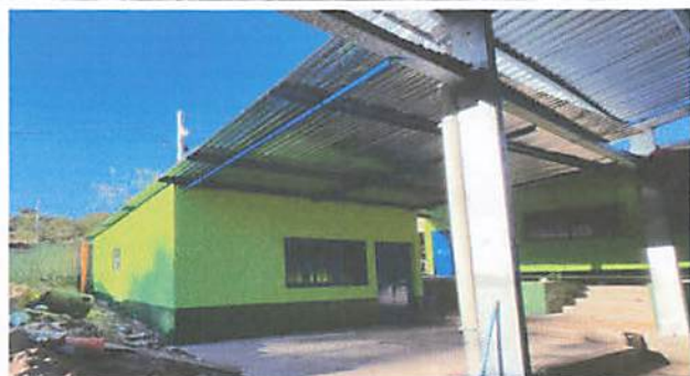
Foto 1: Ampliación, remodelación y mantenimiento de cocina. (levantado de pared para ampliación, construcción de gabinetes, remodelación y colocación de plancha, instalación de lavaplatos, mantenimiento de red eléctrica, piso y techo)
