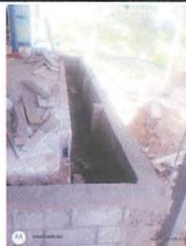
Foto 2: reparación de muro de contención/escenario
