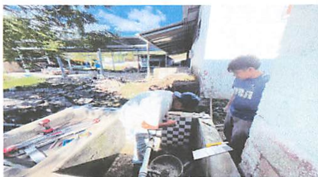
Foto 9: forrado de pila con azulejo.
