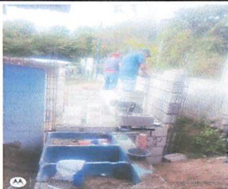
Foto 1: Ampliación, remodelación y mantenimiento de cocina. (levantado de pared para ampliación, construcción de gabinetes, remodelación y colocación de plancha, instalación de lavaplatos, mantenimiento de red eléctrica, piso y techo)
