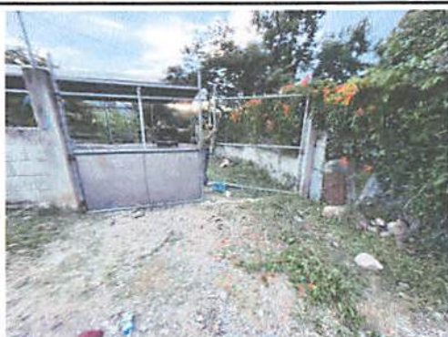
Foto 11: reparacion y pintura de porton principal.
