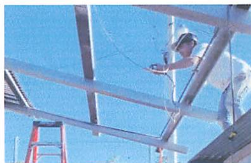
Foto 6: reparación e instalación de tendido eléctrico de la cocina
