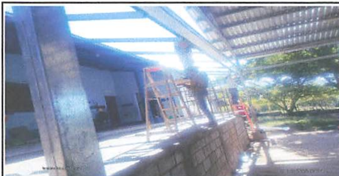
Foto 8: cambio de techo del escenario
