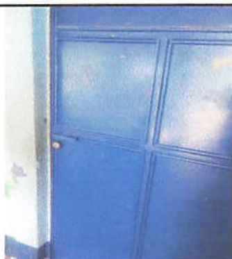
Foto 12: cambio de chapas, en puertas
