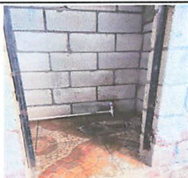
Foto 5: Instalación de 3 nuevos sanitarios.
