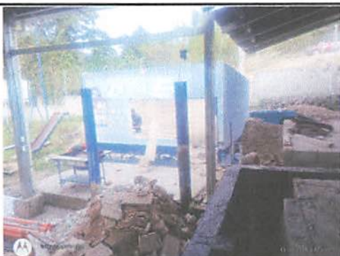
Foto 3: ampliación de ventana, colocación de balcón
