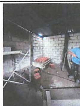
Foto 4: reubicación, remodelación de poyo artesanal.
