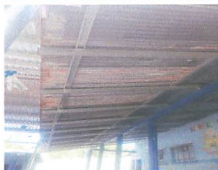
Foto 8: cambio de techo del escenario
