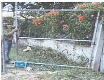
Foto 11: reparacion y pintura de porton principal.
