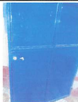
Foto 12: cambio de chapas, en puertas
