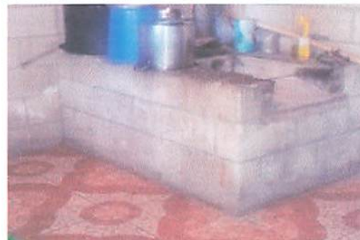
Foto 4: reubicacion, remodelacion de poyo artesanal.
