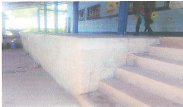
Foto 2: reparacion de muro de contencion/escenario
