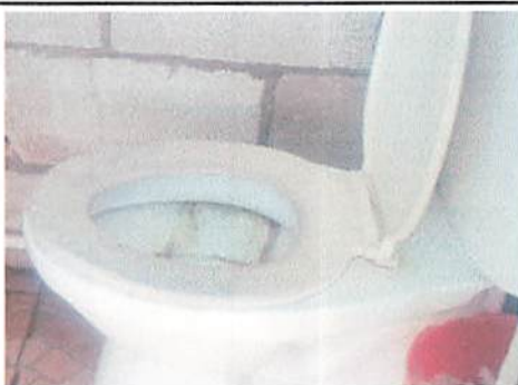
Foto 5: Instalacion de 3 nuevos sanitarios.
