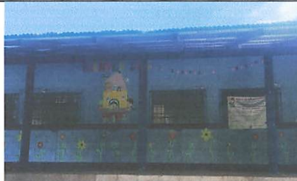
Foto 10: Pintura de interior y exterior de todo el establecimiento
