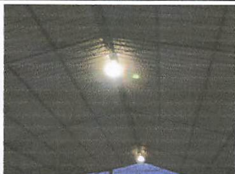
Foto 9: Reparación de cableado de energía en el techo de la cancha
