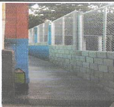
Foto 3: Reparación y colocación de nuevo block para pared ya que en el estado en el que se encuentra, corren riesgo los niños.
