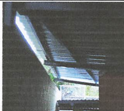
Foto 10: Ampliación de techo para evitar problemas en tiempo de invierno
