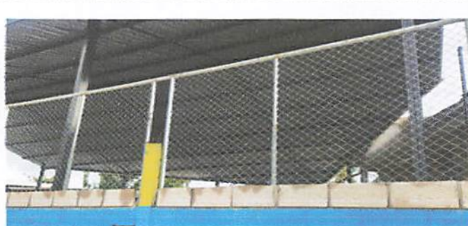
Foto 6: Colocación de nueva malla para todo el circulado de la escuela
