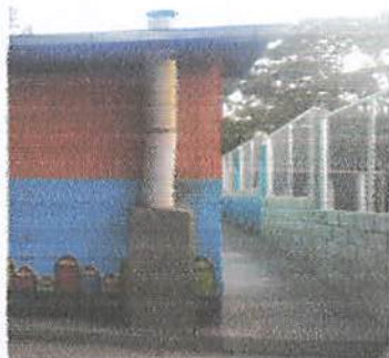
Foto 7: Reparación de chimenea
