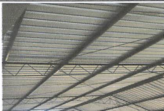
Foto 1: Mantenimiento a estructura de techado de cancha
