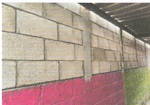
Foto 5: Quitar malla y colocar block para seguridad de una parte del circulado de la escuela para evitar ingreso de animales peligrosos
