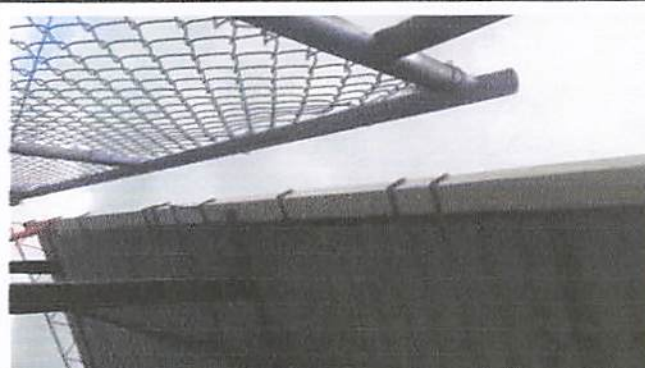
Foto 2: Cambio de canales y bajada de aguas pluviales
