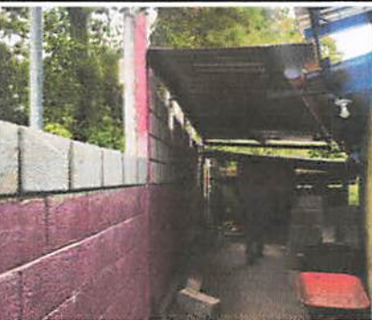
Foto 5: Quitar malla y colocar block para seguridad de una parte del circulado de la escuela para evitar ingreso de animales peligrosos
