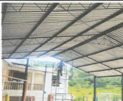
Foto 9: Reparación de cableado de energía en el techo de la cancha
