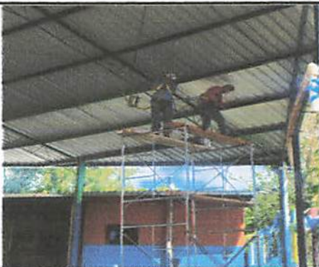
Foto 1: Mantenimiento a estructura de techado de cancha
