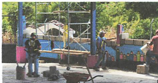
Foto 6: Colocación de nueva malla para todo el circulado de la escuela
