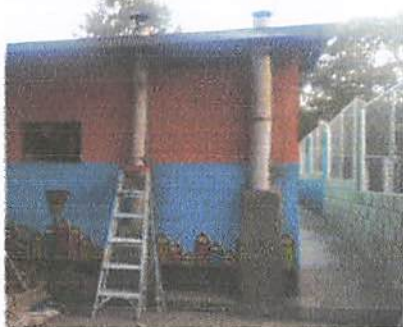
Foto 7: Reparación de chimenea
