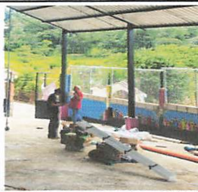
Foto 2: Cambio de canales y bajada de aguas pluviales
