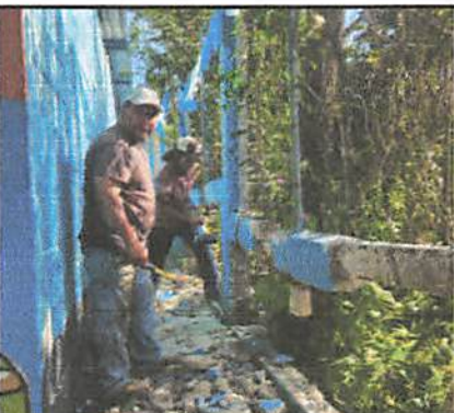
Foto 3: Reparación y colocación de nuevo block para pared ya que en el estado en el que se encuentra, corren riesgo los niños.
