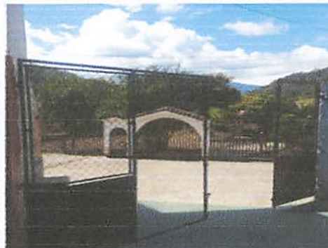
Foto 8: Reparación y remodelación del portón de entrada principal
