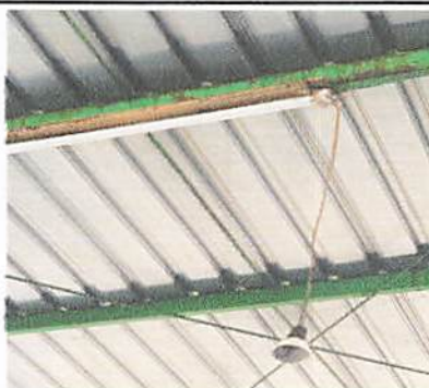
Foto 9: Reparación de cableado de energía en el techo de la cancha
