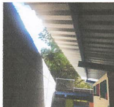
Foto 10: Ampliación de techo para evitar problemas en tiempo de invierno
