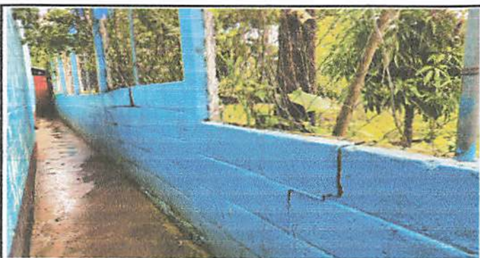
Foto 3: Reparación y colocación de nuevo block para pared ya que en el estado en el que se encuentra, corren riesgo los niños.
