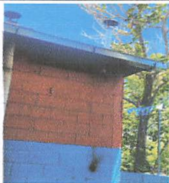
Foto 7: Arreglo y colocación de tubos para chimenea
