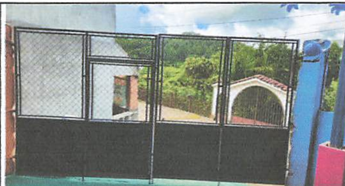
Foto 8: Reparación y remodelación del portón de entrada principal
