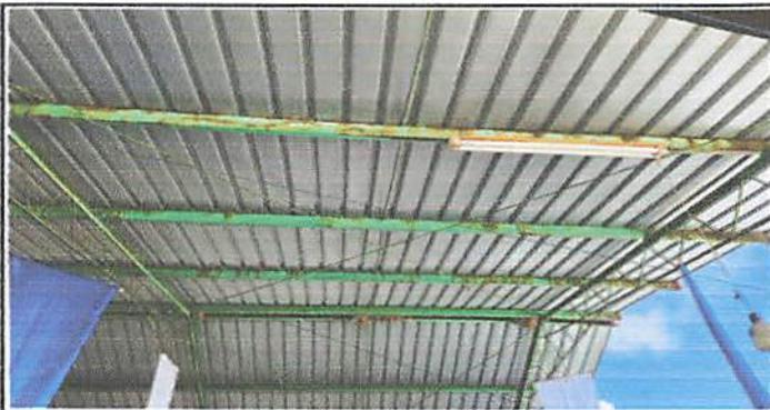
Foto 1: Mantenimiento a estructura de techado de cancha
