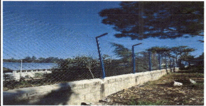
Foto 2: CAMBIO DE MALLA PERIMETRAL
