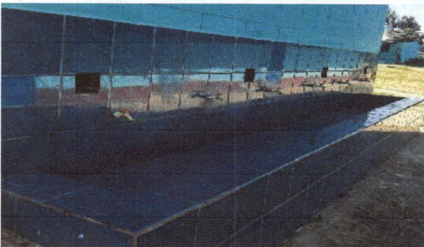
Foto 5: REPARACIÓN DE RED DE AGUA POTABLE
