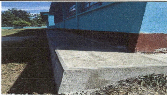
Foto 3: MURO DE CONTENCIÓN EN AULAS
