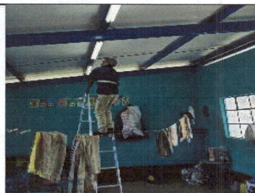
Foto 4: REPARACIÓN DEL SISTEMA ELECTRICO
