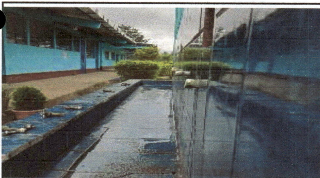
Foto 5: REPARACIÓN DE RED DE AGUA POTABLE
