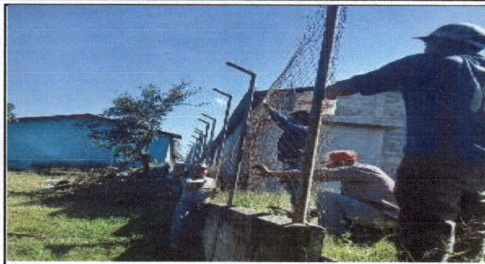
Foto 2: CAMBIO DE MALLA PERIMETRAL
