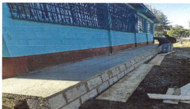
Foto 3: MURO DE CONTENCION EN AULAS
