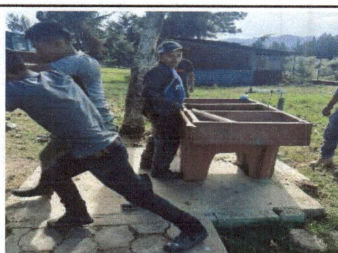
Foto 6: REPARACIÓN DE RED DE AGUA POTABLE
