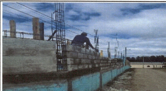
Foto1: LEVANTADO DE PARED PERIMETRAL
