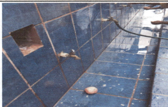
Foto 5: REPARACIÓN DE RED DE AGUA POTABLE
