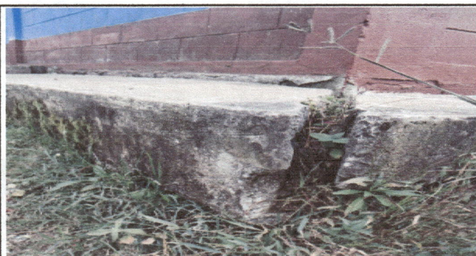
Foto 3: MURO DE CONTENCIÓN EN AULAS
