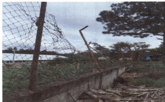
Foto 2: CAMBIO DE MALLA PERIMETRAL
