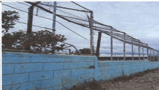
Foto1: LEVANTADO DE PARED PERIMETRAL
