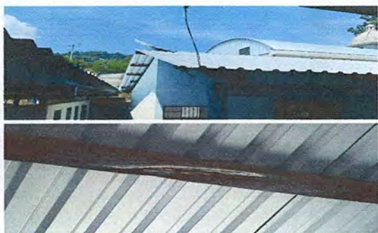
Foto 3: Estructura metálica y techado para dos salones y dirección.
