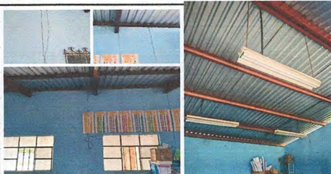
Foto 4: Cambio de sistema eléctrico y alumbrado de tres salones y dirección.
