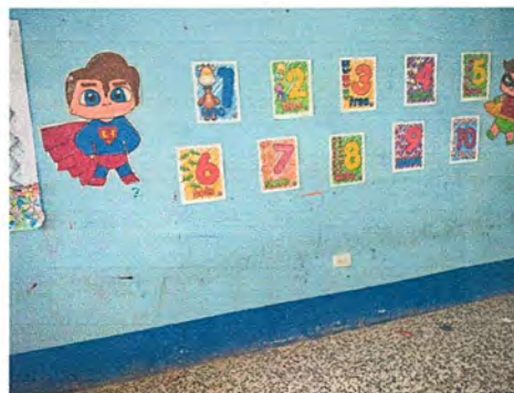
Foto 2: Pintura interior y exterior para salón de preprimaria
