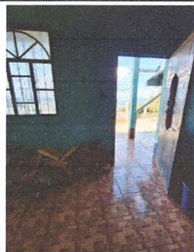
Foto 4. Mantenimiento a estructura de puerta de metal.
