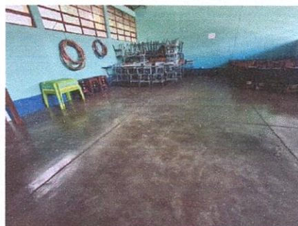
Foto1.4: Suministro e instalación de sistema eléctrico en bodegas.
