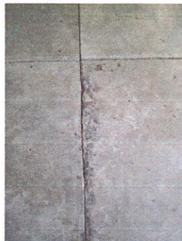
Foto 3. Sustitución de piso de torta de concreto por piso cerámico.
