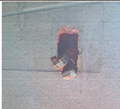
Foto1.1: Suministro e instalación de sistema eléctrico en 4 aulas, cocina, baños, bodegas, canchas, y dirección
