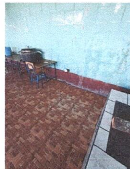
Foto1.2: Suministro e instalación de sistema eléctrico cocina.
