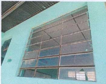
Foto 7: Sustitución de vidrios
