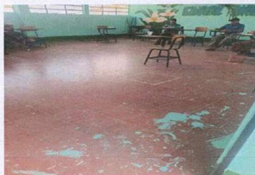
Foto 4: Sustitución de piso ceramico aula 3
