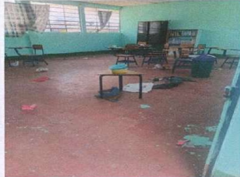
Foto 2: Sustitución de piso ceramico aula 1
