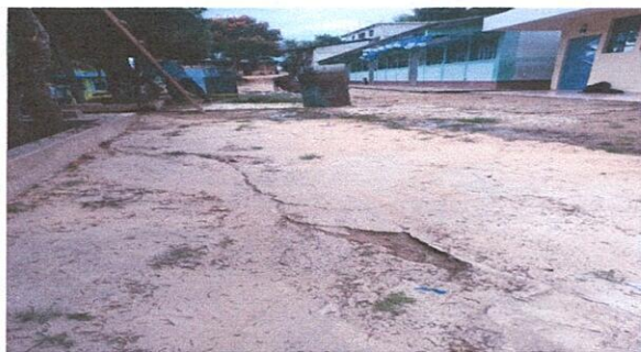
Foto1: Suministro e Instalación de Adoquin Tradicional de 22X24X10 cms por cambio en patio de pavimento en mal estado
