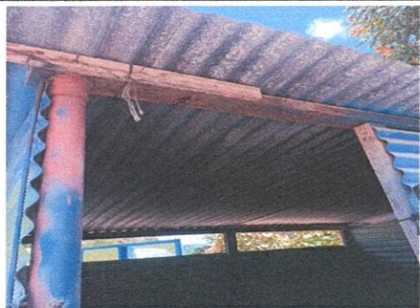
Foto 3: Suministro de instalación de Techado y en estructura de Pileta 31 m2
