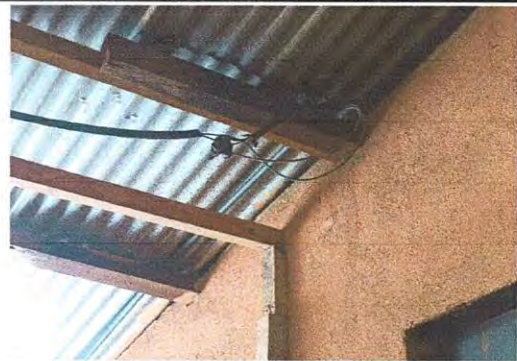
Foto 12: Reparación del sistema electrico de coina y bodega consistente en: cabiado, 10 focos, 7 apagadores, 5 tomacorrientes, 10 plafoneras.
