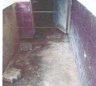
Foto 20: Suministro e instalación de puertas prefabricadas para baños 190 cm. X 84 cm.
