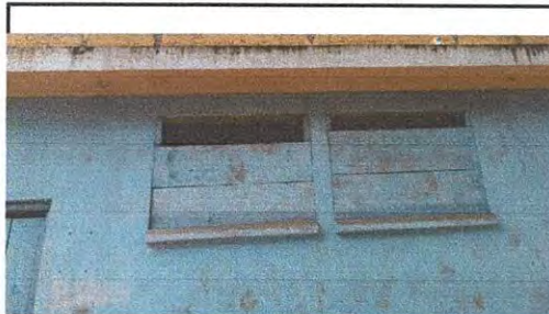
Foto 14: Suministro e instalación de ventanas metálicas de bodega 102.5 x 18.5 centímetros y 230.5 x 94 centímetros.
