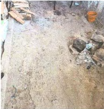
Foto 9: Suministro y Sustitucion de piso de torta de cemento por piso cerámica bodega de cocina
