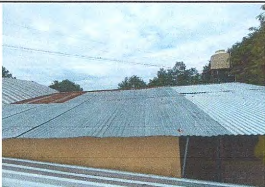
Foto 3: Sustitucion y Suministro de capote
