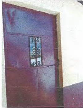
Foto 21: Suministro e instalación de dos chapas marca yale para puerta de aula
