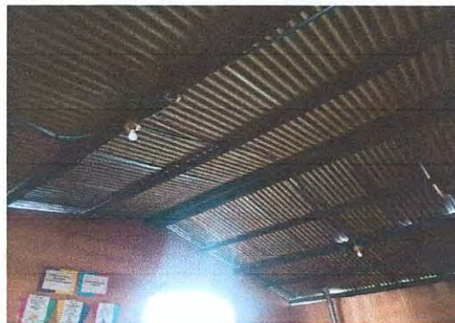
Foto 2: Suministro y sustitucion de estructura metalica de techo
