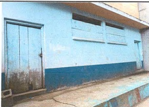
Foto 15: Suministro e instalación de una puerta prefabricada para bodega
