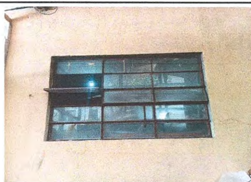
Foto 4: Suministro e instalación de 2 ventanas de estructura metálicas
