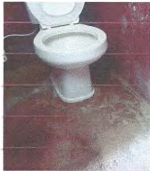
Foto 19: Suministro e instalación de azulejo y cerámica para piso de baños
