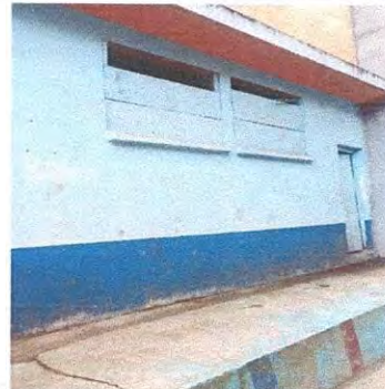
Foto 22: Suministro e instalación de 3 balcones de bodega, 230 cm. X 94 cm.
