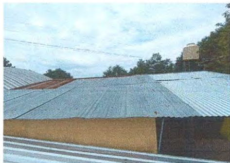
Foto1: Suministro y sustitucion de Techo
