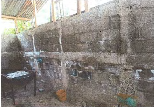
Foto 7: Reparación y sernido de muro de bodega de cocina
