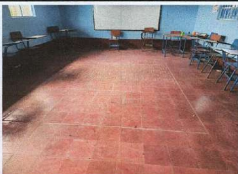
Foto 3: Sustitución de piso por ceramico aula 1
