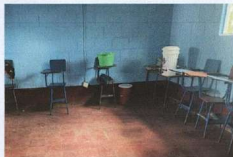
Foto 10: Pintura en muros interiores de tres aulas.
