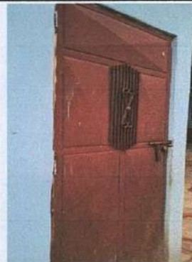
Foto 8: Sustrucción de puertas de servicio sanitarios con chapa.
