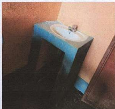
Foto 7: Sustrucción de lavamanos
