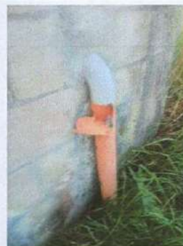
Foto 12: Sustrucción de tubos de drenaje.
