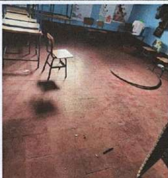
Foto 5: Sustitución de piso por ceramico aula 3
