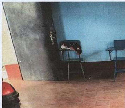
Foto 2: Mantenimiento a estructuras de puerta de metal con chapa
