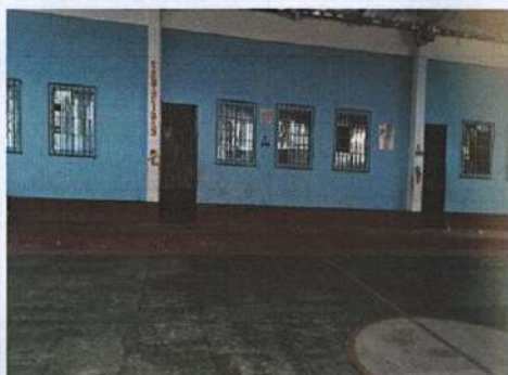
Foto 11: Pintura en muros exteriores de 3 aulas.
