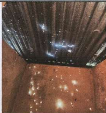
Foto 1: Cambio de techo de sanitarios.
