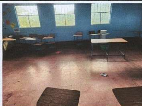
Foto 4: Sustitución de piso por ceramico aula 2
