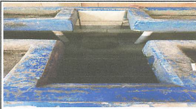
Foto 2: SUSTITUCION DE DRENAJE DE AGUA GRIS, PARA 4 LAVABO EN PILETA EXISTENTE.
