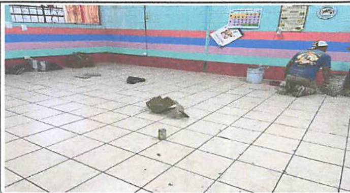
Foto 1: SUSTITUCION DE PISO EXISTENTE POR PISO CERAMICO.
