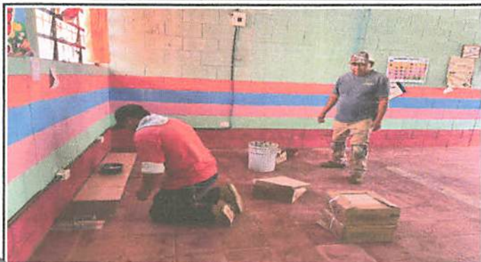
Foto1: SUSTITUCION DE PISO EXISTENTE POR PISO CERAMICO.
