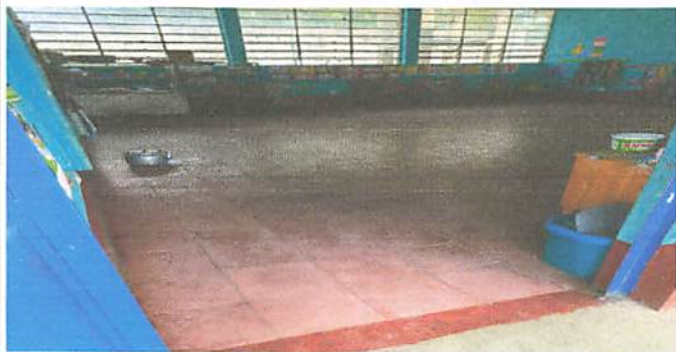
Foto 1: SUSTITUCION DE PISO EXISTENTE POR PISO CERAMICO.
