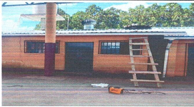
Foto 1: CANALES INSTALADAS EN FRENTE DE COCINA.
