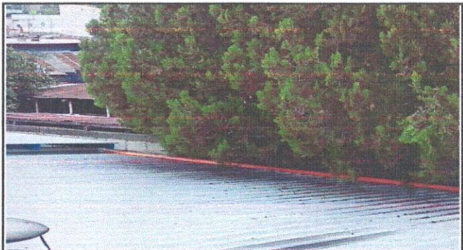
Foto 4: CANALES INSTALADAS ATRÁS DE COCINA.
