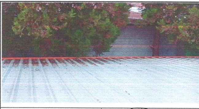
Foto 5: CANALES INSTALADAS ATRÁS DE ANTA
