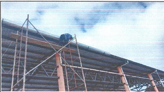
Foto 3: CAMBIO DE CANALES EN TECHADO DE CANCHA.
