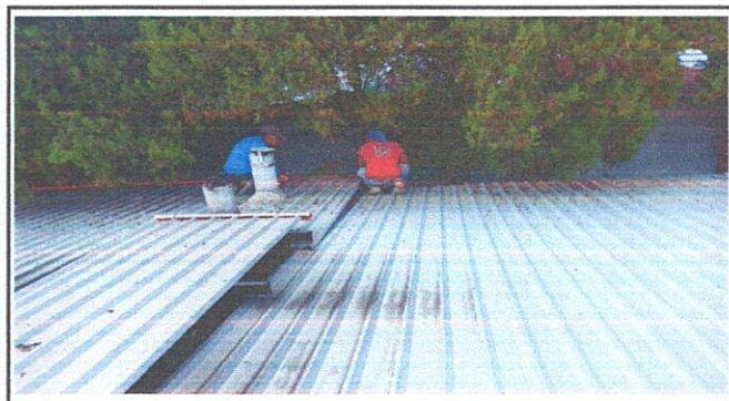
Foto 4: INSTALACION DE CANALES ATRÁS DE COCINA.
