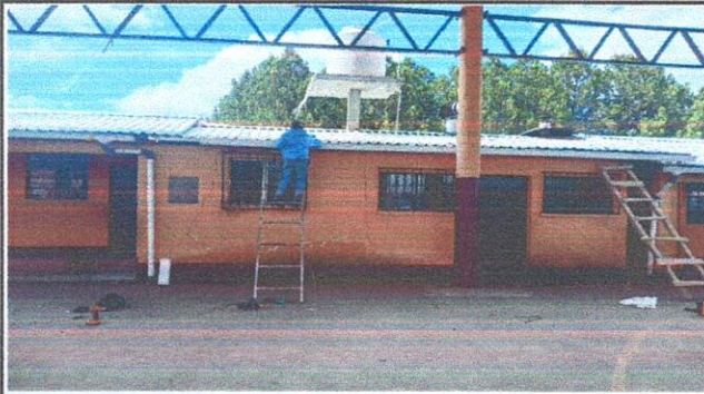
Foto 1: INSTALACION DE CANALES EN TECHADO EN FRENTE DE COCINA.
