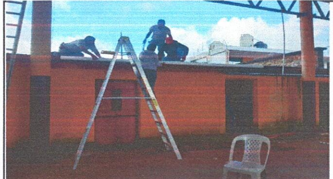
Foto 2: CAMBIO DE TECHADO Y SUMINISTRO DE CANALES DE BODEGA E INSTALACION DE TUBERIA.
