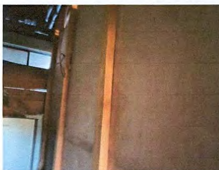
Foto 7.1: SUMINISTRO E INSTALACIÓN DE TABLAYESO DIVISORIO DE BODEGA DE COCINA
