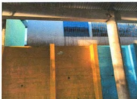
Foto 12.2: SUMINISTRO E INSTALACIÓN DE BARANDA METÁLICA DE CANCHA (0.75x8.25mts.)
