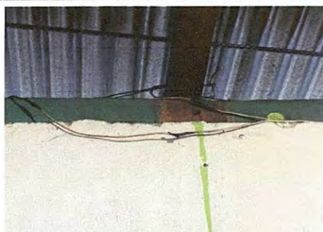
Foto 7: SUMINISTRO E INSTALACIÓN DE TABLAYESO DIVISORIO DE BODEGA DE COCINA
