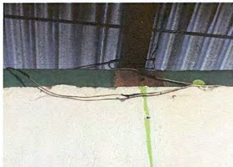
Foto 9: CORRECCIÓN DE SISTEMA ELECTRICO DE COCINA, INCLUYE: CABLEADO+TOMACORRIENTES+ FOCO + APAGADORES
