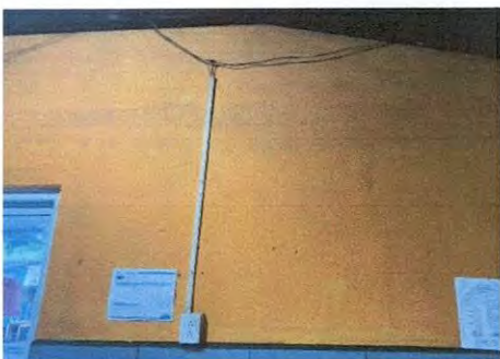
Foto 9.2: CORRECCIÓN DE SISTEMA ELECTRICO DE COCINA, INCLUYE: CABLEADO+TOMACORRIENTES+ FOCO + APAGADORES
