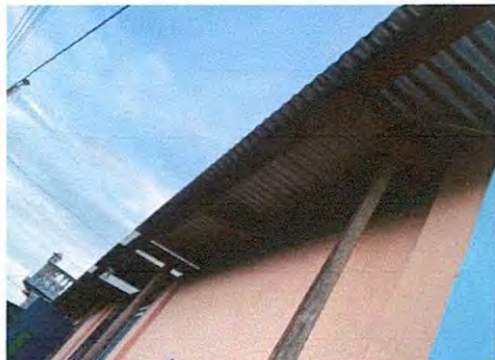
Foto 3.1: SUMINISTRO E INSTALACIÓN DE CANALES + BAJADAS DE DRENAJE PLUVIAL CON TUBERÍA PVC DE 3" DE CUBIERTA DE COCINA
