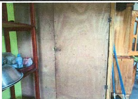
Foto 8: SUMINISTRO E INSTALACIÓN DE PUERTA PREFABRICADA CON HERRAJES PARA BODEGA DE COCINA (0.90X2.05mts)
