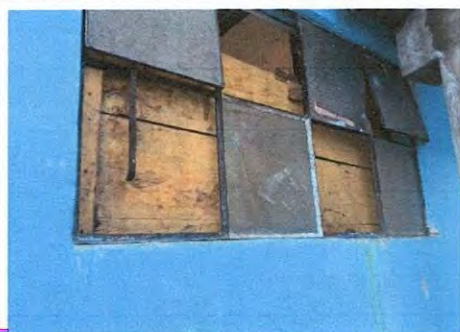
Foto 4.1: SUMINISTRO E INSTALACIÓN DE VENTANAS PVC SERIE 60 COLOR BLANCO DE COCINA
