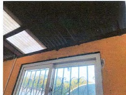
Foto 10: REPOSICIÓN DE HILADAS DE BLOCK + APLICACIÓN DE ACABADOS DE COCINA
