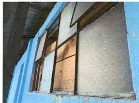
Foto 4: SUMINISTRO E INSTALACIÓN DE VENTANAS PVC SERIE 60 COLOR BLANCO DE COCINA
