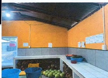
Foto 5.1: INSTALACIÓN DE GABINETES AEREOS + APLICACIÓN DE ACABADOS (AZULEJO) DE COCINA
