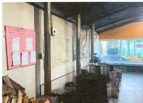
Foto 6.1: SUMINISTRO E INSTALACIÓN DE EXTRACTOR DE COCINA
