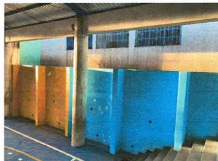
Foto 12.1: SUMINISTRO E INSTALACIÓN DE BARANDA METÁLICA DE CANCHA (0.75x8.25mts.)
