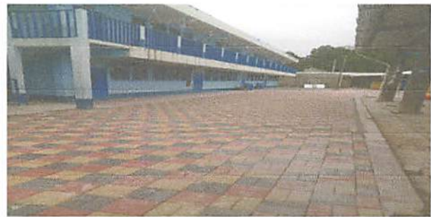
Foto 2: FINALIZACION DE COLOCACION DE PISO PATIO EXISTENTE POR ADOQUIN DECORATIVO
