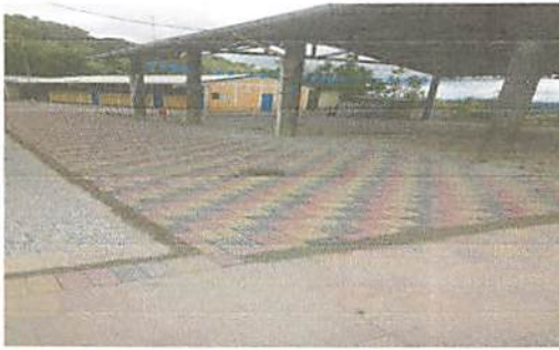
Foto1: FINALIZACION DE COLOCACION DE PISO PATIO EXISTENTE POR ADOQUIN DECORATIVO.
