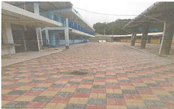
Foto 3: FINALIZACION DE COLOCACION DE PISO PATIO EXISTENTE POR ADOQUIN DECORATIVO
