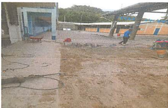
Foto 3: COLOCACION DE PISO PATIO EXISTENTE POR ADOQUIN DECORATIVO.
