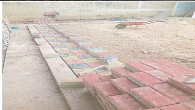
Foto 2: COLOCACION DE PISO PATIO EXISTENTE POR ADOQUIN DECORATIVO.
