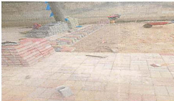
Foto1: COLOCACION DE PISO PATIO EXISTENTE POR ADOQUIN DECORATIVO.
