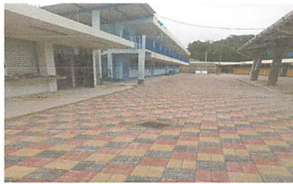
Foto 4: INSTALACION DE DRENAJE PLUVIAL DONDE SE RECOLECTARA AGUA PLUVIAL
