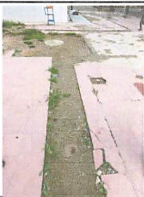
Foto1: PATIO DETERIORADO ES NECESARIO LA SUSTITUCION DE PISO PATIO POR ADOQUIN
