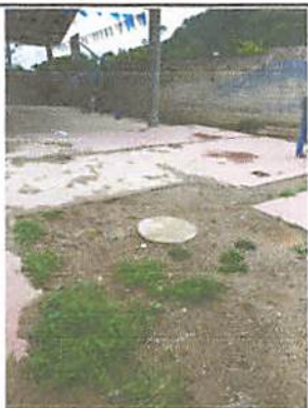
Foto1: PATIO DETERIORADO ES NECESARIO LA SUSTITUCION DE PISO PATIO POR ADOQUIN
