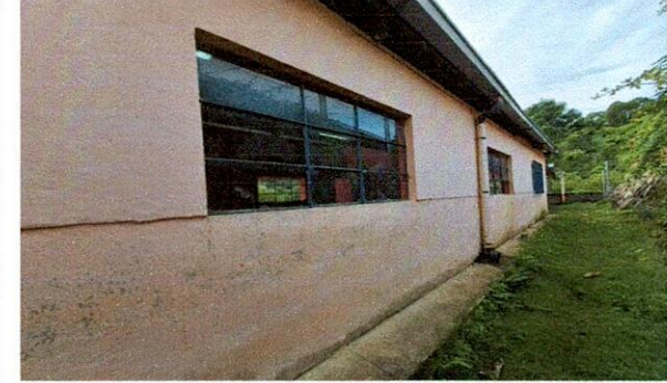
Foto 4: Sustitución de ventana en aula
