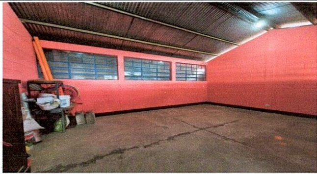
Foto1: instalación de piso cerámico en cocina, zócalo, cernido, plancha de leña, remodelación de puerta y ventana, colocación ventana, pila, base para tinaco, tinaco,
