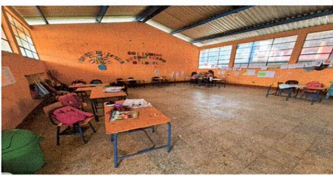
Foto 3: Instalación de piso cerámico en una 3, módulo 2
