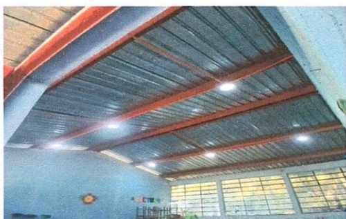
Foto 5: Reparación de sistema Electrico, consistente de instalacion de: plafoneras, focos, tomacorrientes y cableado en el interior y corredor de 9 aulas
