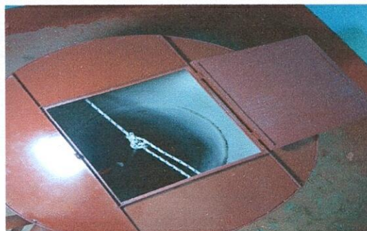
Foto 2: Reparación y mantenimiento de Sistemas/ depósito de Agua
