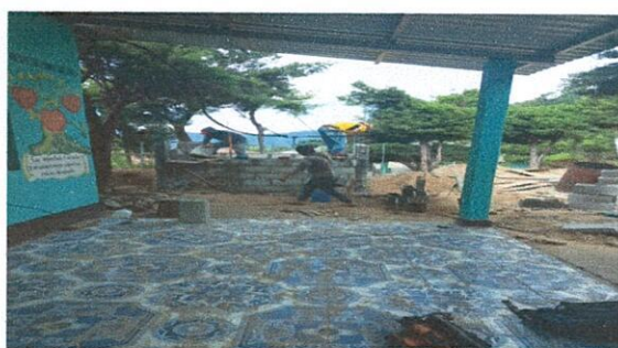
Foto 3: Reparación y mantenimiento de Sisternas/ depósito de Agua
