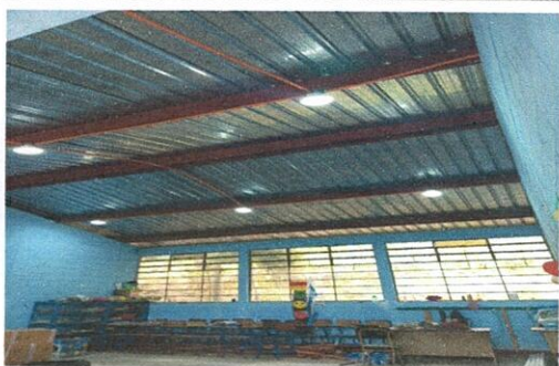
Foto 5: Reparación de sistema Eléctrico, consistente de instalación de: plafoneras, focos, tomacorrientes y cableado en el interior y corredor de 9 aulas
