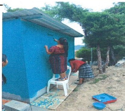
Foto 4: Reparación y mantenimiento de Sisternas/ depósito de Agua
