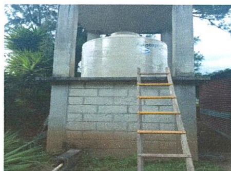
Foto 2: Reparación y mantenimiento de Sisternas/ depósito de Agua
