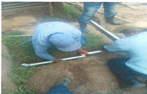
Foto1: Reparación y mantenimiento de Sisternas/ depósito de Agua
